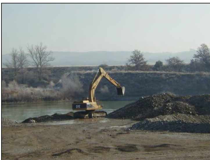
Photo 28 : Exemple d'extraction en eau par pelle mécanique
