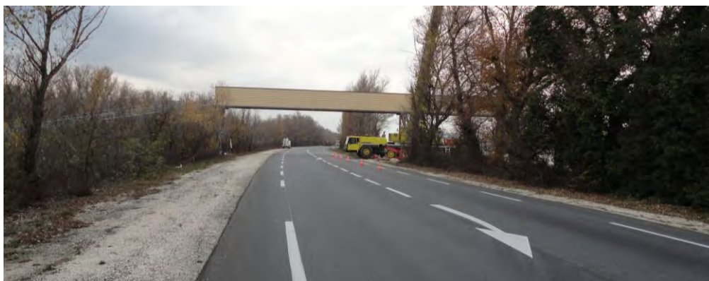
Photographie : Exemple de bande transporteuse (structure droite)
