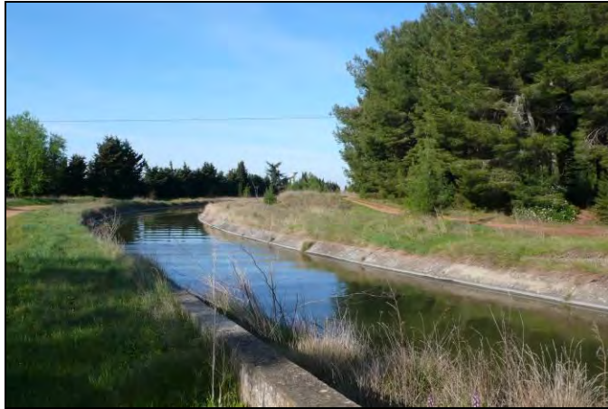
Photo 21 : Le canal des Costières au Nord-Ouest du site, un exemple du système d'irrigation local.
